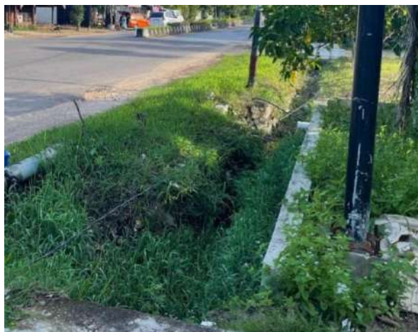
Gambar 4-14 (a) Kondisi Jalan Rusak (b) Jaringan Drainase Tersumbat Semak dan Sampah
